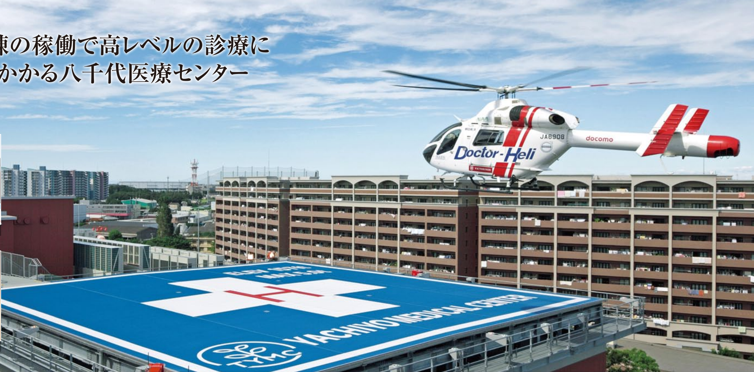
屋上にヘリポートを備えた八千代医療センターの第2病棟。
