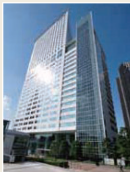
新宿サザンテラス広場となっている小田急サザンタワー前
