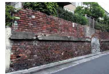
あらかわ遊園に隣接する住宅地には、かつて煉瓦工場だった名残をとどめる煉瓦塀が見られる。
