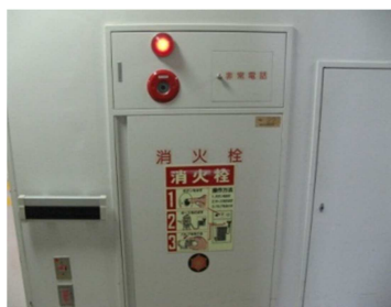
（中央病棟・東病棟）
