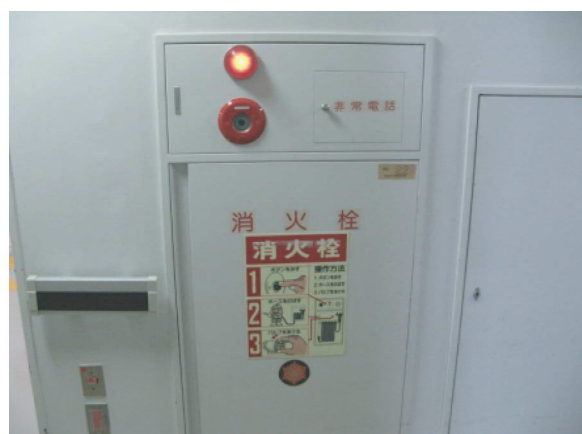
(中央病棟・東病棟)
