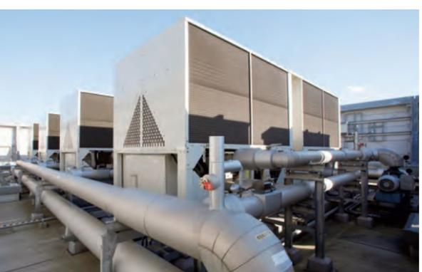
→屋上に設置されている水蓄熱式空調システムの熱源機。蓄熱槽の水は、災害時に生活用水として利用できる。
