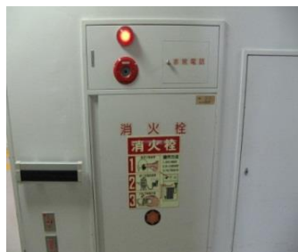
（中央病棟・東病棟）
