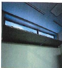
自然排煙による排煙口の例
