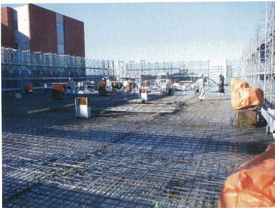
【4階の床面が出来てきました。】
