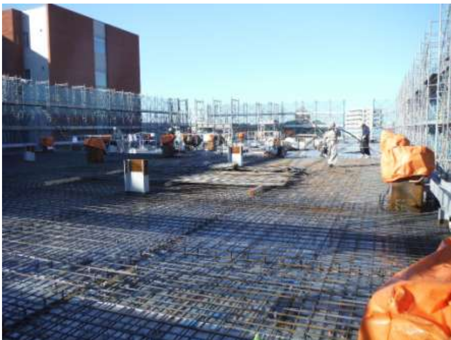
【4階の床面が出来てきました。】
